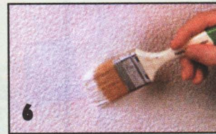
Теперь остаётся только подкрасить исправленное место, причём так, чтобы не было заметно стыков между обоями и вставкой.
