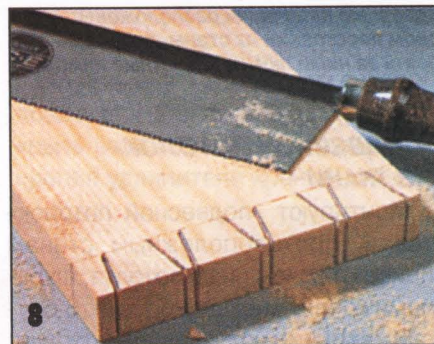
8 Пропилы «ласточкиных хвостов» делают со смещением от линии разметки на участках, идущих в отходы. После этого выбирают пазы начисто.
