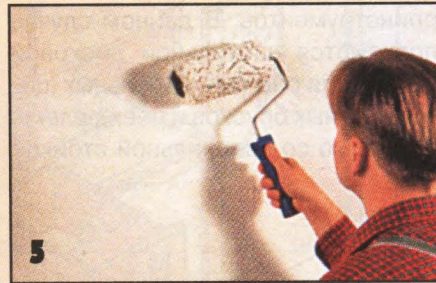
Дав клею высохнуть, обои покрывают краской (здесь — укрывистой дисперсионной).
