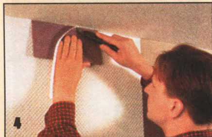
На переходах у потолка и плинтуса полотнища аккуратно обрезают ножом.
