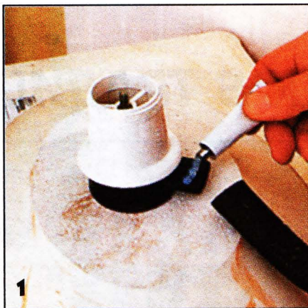
Переливной шланг раковины крепят к сливу на силиконовом клее.
